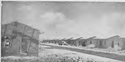
Construccion di e 74 casanan nobo di Home Building Foundation ta basta leuwa cuba (aki riba), y nan lo keda cla na fin di aña. Cuarenta y ocho di e casanan lo tin cinco kamber y e otro hini-sete lo tin cuater kamber. E casanan aki ta di tercer grupo cu Home Building Foundation ta laga traha, y nan ta keda p'atras banda di p'hasa di Lagoville.
